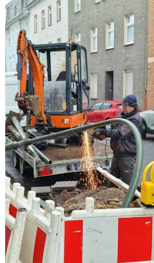
Die denkmalgeschützten Masten aus nahtlosen Mannesmannröhren werden zerlegt und wandern auf den Schrottplatz © Dietmar Erlebach
